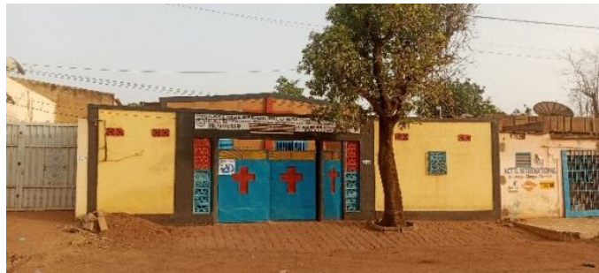
Photo n°10 : Temple implanté dans un bâtiment, quartier Hamdallaye
