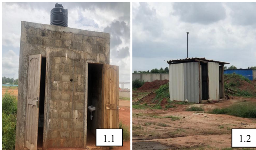
Source : ADJAKPA T. T., vues prises en juillet 2022.
