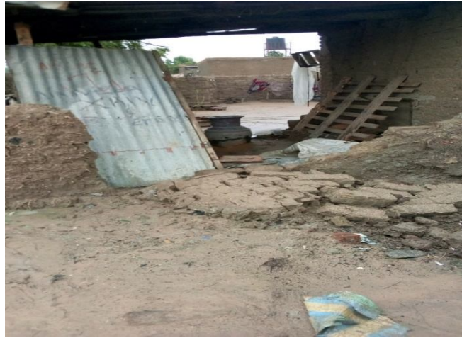
Source : DAUDINGADE C., vue prise en septembre 2020.
