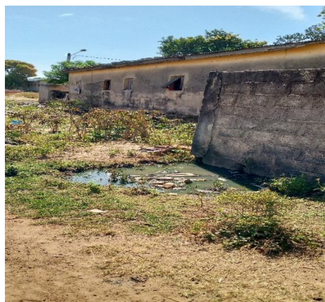
Photo n°1 : Une fosse septique à ciel ouvert derrière une fenêtre ouverte au quartier Bromakoté
