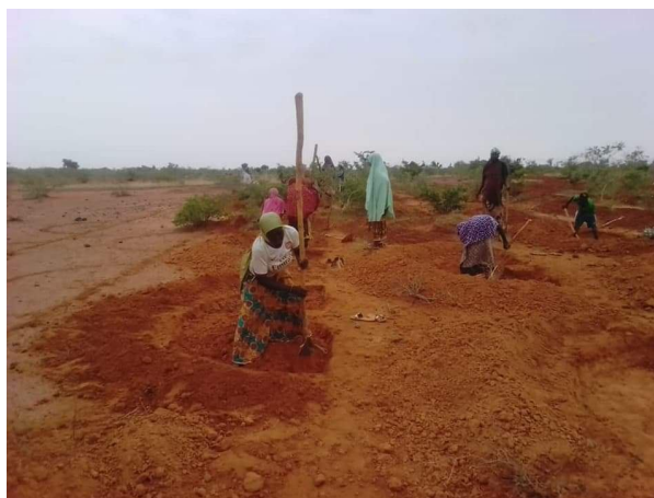
Photo n°2 : Travaux de construction des demi-lunes forestières sur le plateau de Margou Bene à Birni N'Gaouré
