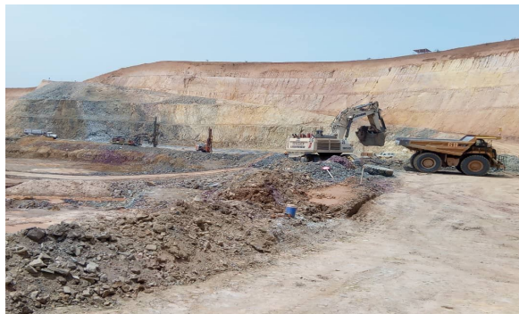
Photo n°1 : Une carrière de la SMK
