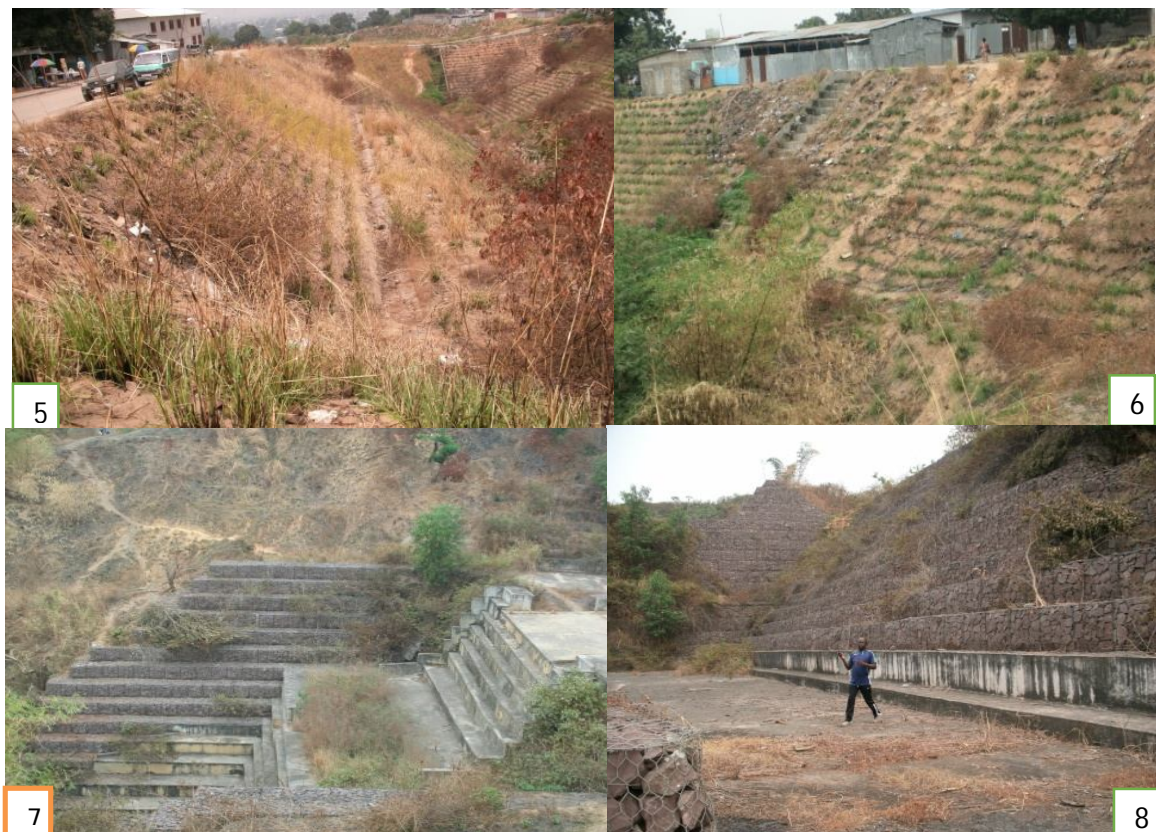
Planche n°2 : Ravins traités par des méthodes biologiques et mécaniques dans l'arrondissement 9 Djiri
