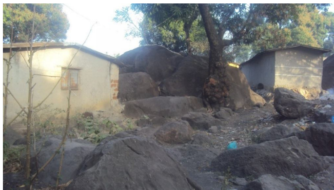
Source : BOHOSSOU N. S., photo prise en 2018.
